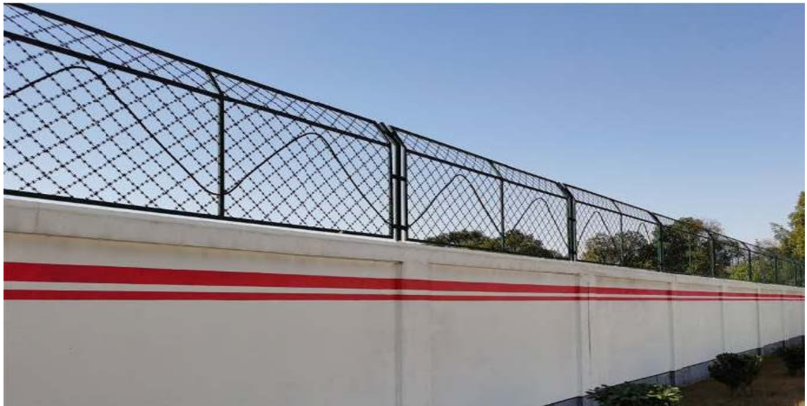
Figure 4 - 安裝在蜿蜒形圍欄頂部部分的光纜照片。
