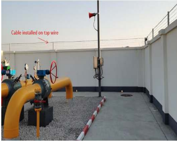
Figure 5 - 安裝在頂部纜線上的柵欄頂部的光纜
